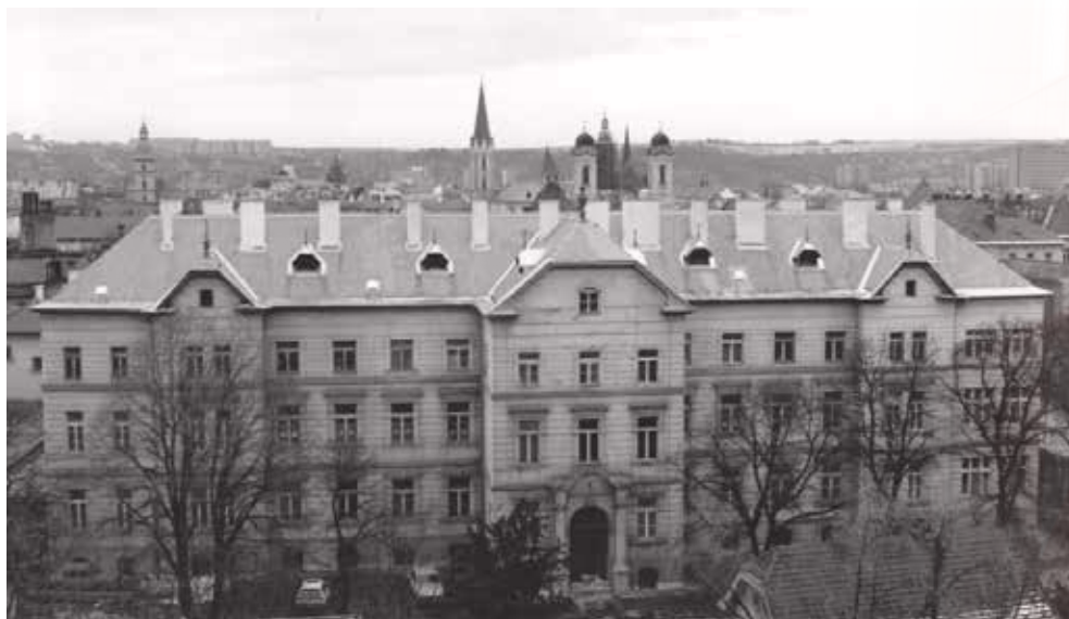
Stará budova Detskej fakultnej nemocnice na Moyzesovej ulici
